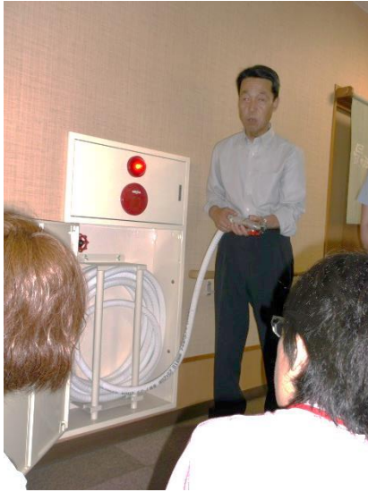
消火用散水栓使用訓練①
